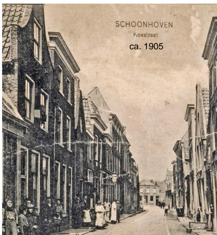
Afb. 6 Koestraat, naar het Noorden gezien; links, huidige nummers 120, 122, 124a, b, 126, zijn 17de-eeuwse panden.
