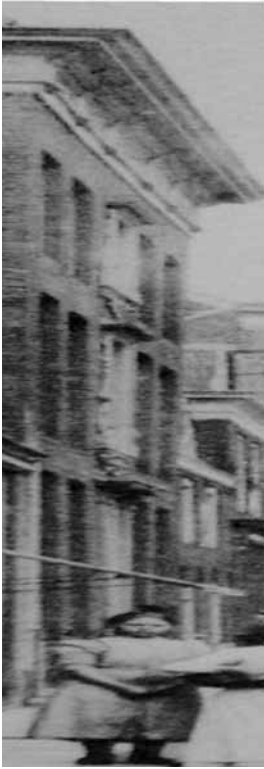
Afb. 9: Gemanipuleerd beeld van het pand Koestraat 104. Detail van afb. 7.
