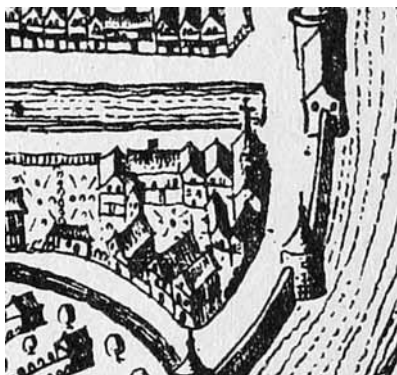
Afb. 4: Plattegrond van Schoonhoven; West boven. Detail: Oude mannen- en vrouwenhuis, Oude Haven ter hoogte van de huidige huisnummers 31-33. Hierin bevond zich van 5 december 1807 tot 23 maart 1809 de Keurkamer van het Koninkrijk Holland. Situatie omstreeks 1657.
